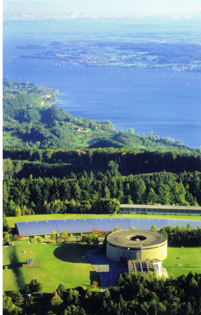
Bild 1 Wasserwerk Sipplinger Berg
