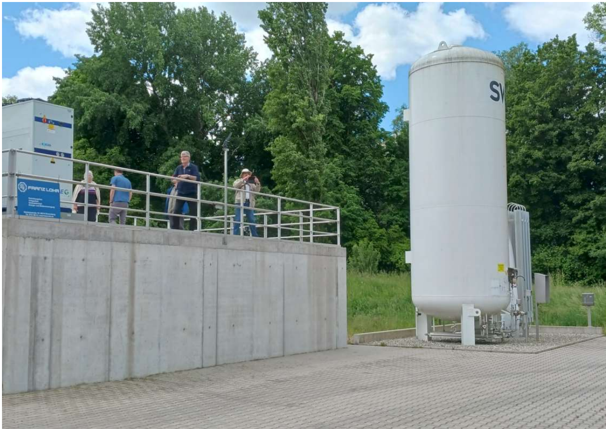
Bild 4 4. Reinigungsstufe mit Sauerstofftank
