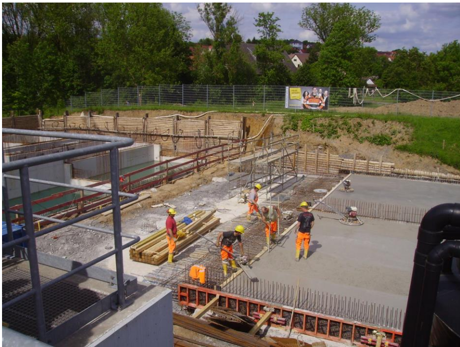
Abb. 6. Baustelle Spurenstoffelimination Kläranlage Öhringen (Foto: Elger)
