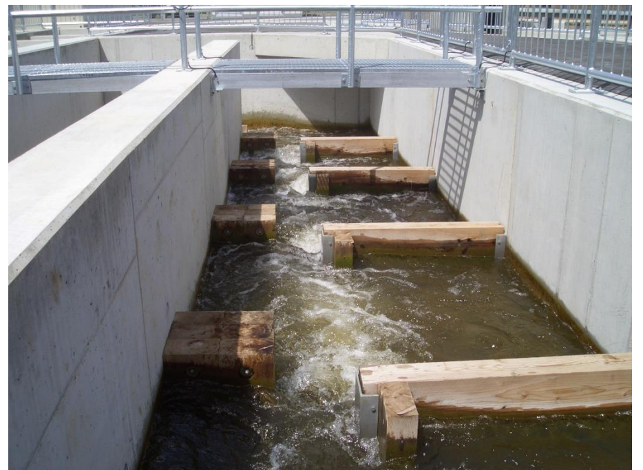
Abb. 4. Beckenschlitzpass am Kocherwehr in Künzelsau (Foto: Engelhardt)
