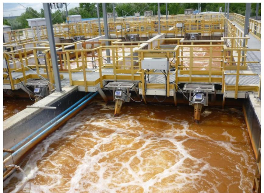
**Abb. 3.** Grubenwasseraufbereitungsanlage Schleenhain, Wendelbelüfter (Foto: Welteke)
